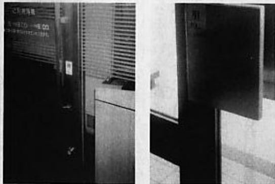
図4 引いて開けたくなるドア(左)と、押して開けたくなるドア
